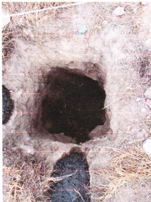
FOTO 05 – ESCAVAÇÃO MANUAL DE VALA PARA VIGA BALDRAME (INCLUINDO ESCAVAÇÃO PARA COLOCAÇÃO DE FÓRMAS). AF_06/2017
