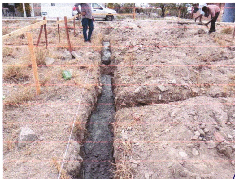
FOTO 05 – ESCAVAÇÃO MANUAL DE VALA PARA VIGA BALDRAME (INCLUINDO ESCAVAÇÃO PARA COLOCAÇÃO DE FÓRMAS). AF_06/2017
