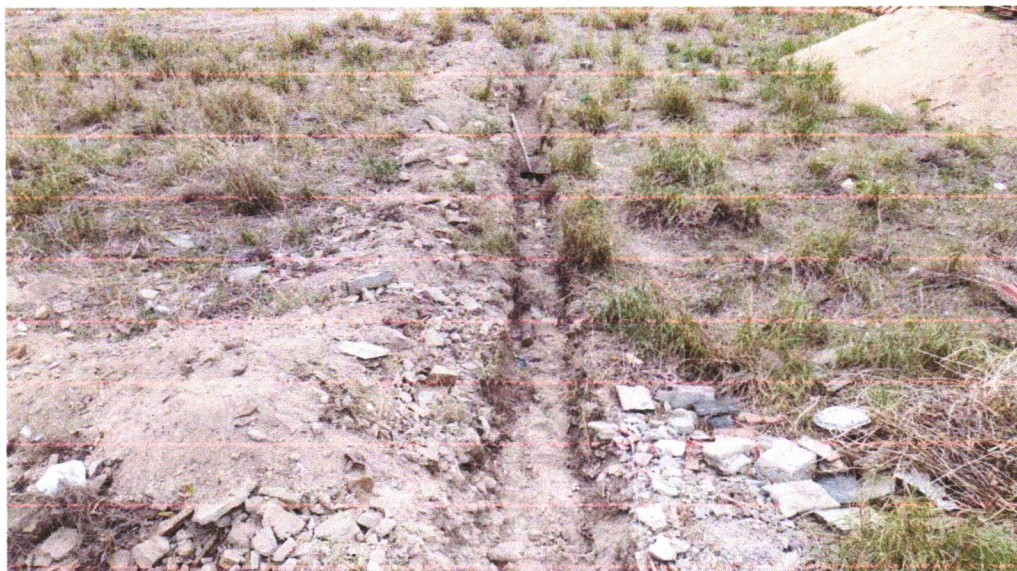
FOTO 02 – ESCAVAÇÃO MANUAL DE VALA PARA VIGA BALDRAME (INCLUINDO ESCAVAÇÃO PARA COLOCAÇÃO DE FÔRMAS), AF_06/2017
