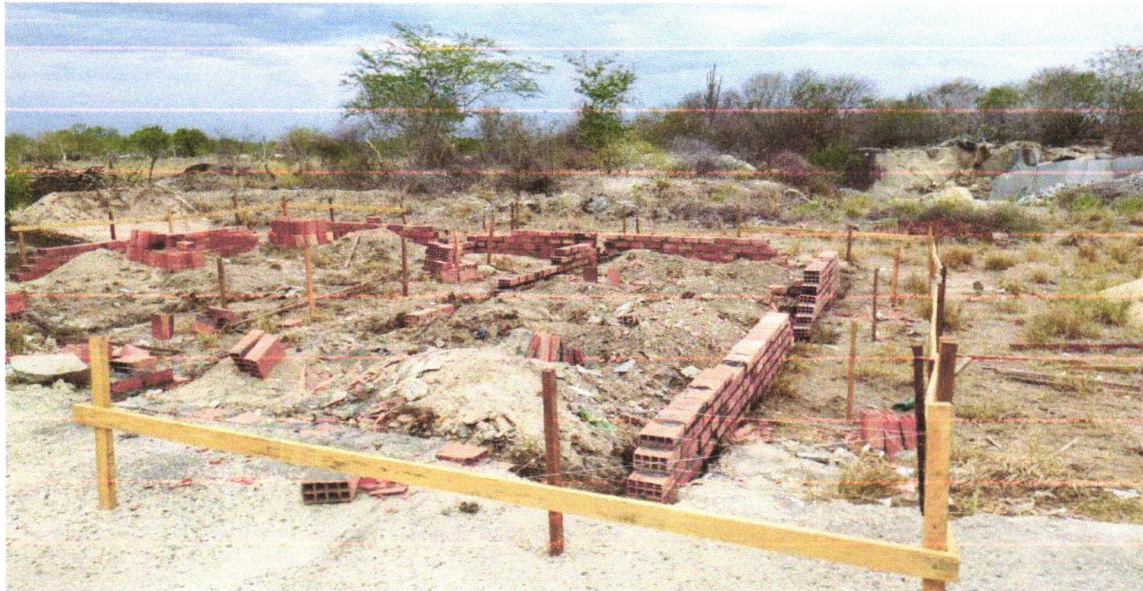
FOTO 9 – LOCAÇÃO CONVENCIONAL DE OBRA, UTILIZANDO GABARITO DE TÁBUAS CORRIDAS PONTALETADAS A CADA 2,00M
