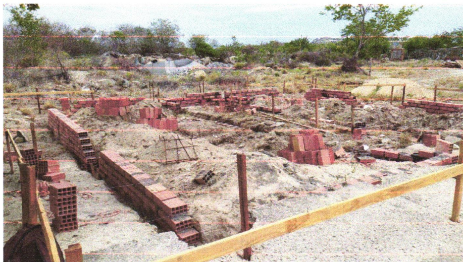
FOTO 08 – LOCAÇÃO CONVENCIONAL DE OBRA, UTILIZANDO GABARITO DE TÁBUAS CORRIDAS PONTALETADAS A CADA 2,00M
