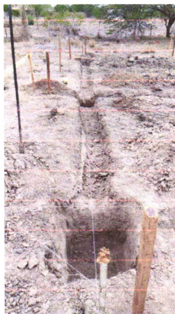
FOTO 03 - ESCAVAÇÃO MANUAL DE VALA PARA VIGA BALDRAME (INCLUINDO ESCAVAÇÃO PARA COLOCAÇÃO DE FÔRMAS). AF_06/2017
