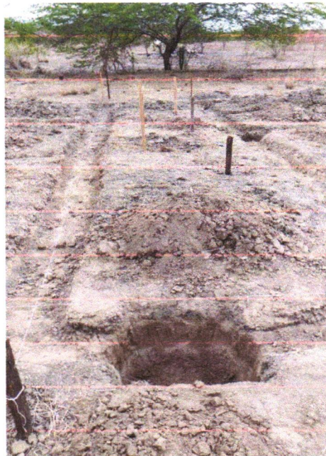
FOTO 03 - ESCAVAÇÃO MANUAL DE VALA PARA VIGA BALDRAME (INCLUINDO ESCAVAÇÃO PARA COLOCAÇÃO DE FÔRMAS). AF_06/2017
